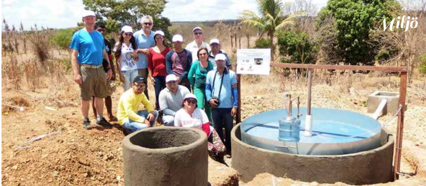
Bioförgasare nr 23 i projekt Biogás Sertão+100 färdigställd i Trapia, Massapé 2016.
