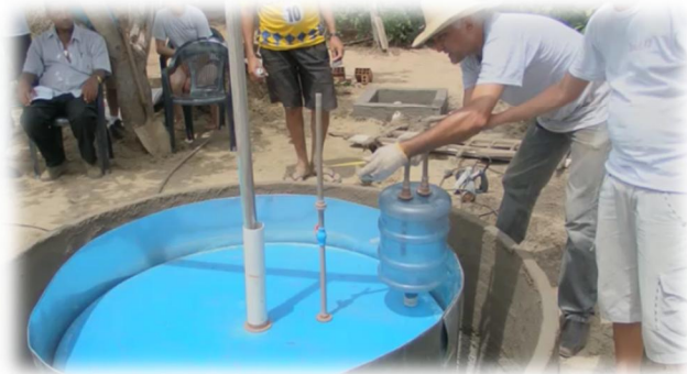
Familjen och teamet nöjda framför den helt färdigställda Bioförgasaren. 1, 5 dagars byggtid betyder nytt rekord!
